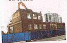
Der Abriss des ehemaligen SKF-Geländes zugunsten eines neuen Einkaufszentrums schreitet voran.
